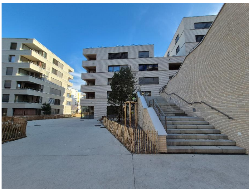
Figure 41 Escalier extérieur au cœur du quartier (mars 2025)
