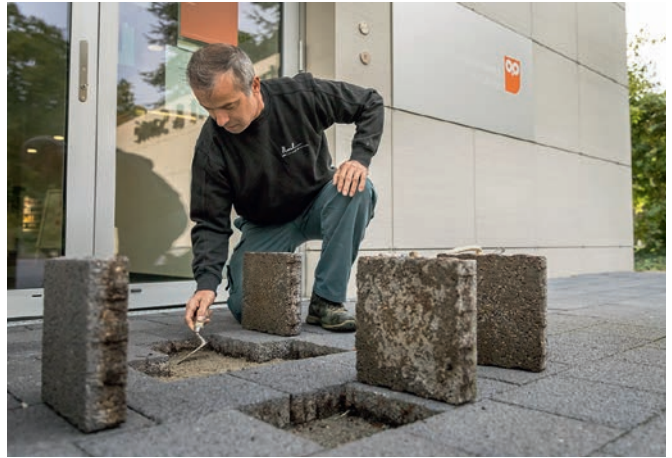
Antonio Cerqueira De Azevedo rehausse quelques pavés devant le Centre sport et santé. Un peu d'eau et de sable, le tour est joué!
