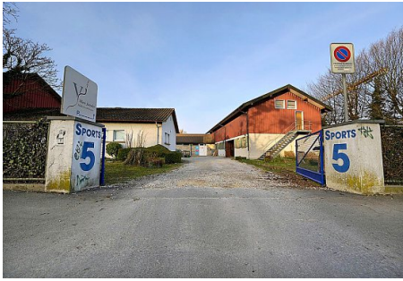
La friche urbaine de l'avenue des Sports 5 serait foncièrement modifiée par le projet. CHRISTIAN BRUN
